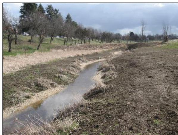
Bild 7: Neuprofiliertes Gewässerbett mit wiedereingebauten Röhrichtsoden
